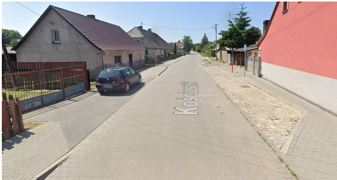
Źródło: Google Street View Ulica Kościuszki od strony ul. Dębrznickiej w Gądkowie Wielkim po inwestycji
