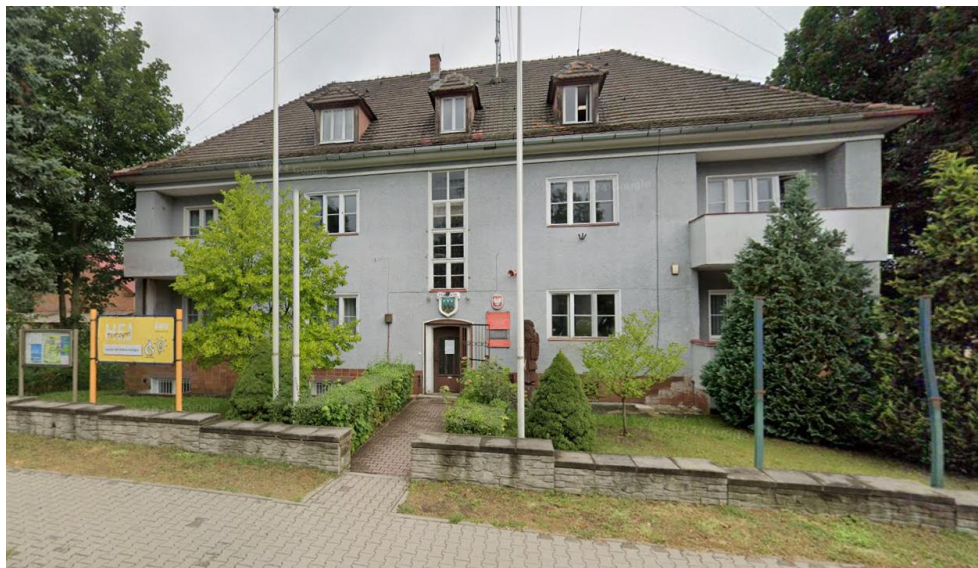
Źródło: Google Street View Urząd Miejski w Torzymiu przed wymianą okien – elewacja frontowa
