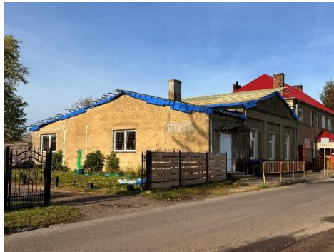
Źródło: Materiały własne Miasta i Gminy Torzym - Budynek świetlicy w Prześlicach w trakcie realizowanej wymiany poszycia dachowego
