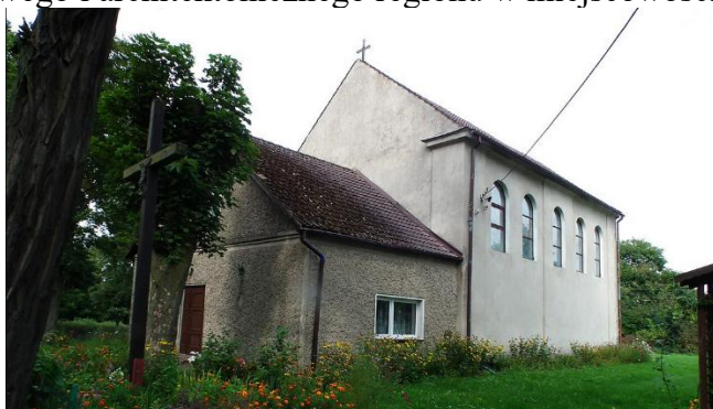
Źródło: Materiały własne Miasta i Gminy Torzym - Wnętrze/elewacja kościoła filialnego w Prześlících przed rozpoczęciem głównych prac
